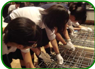
鉄筋結束作業
