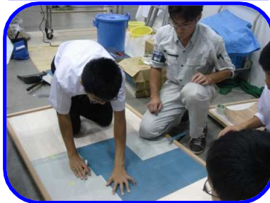
床タイル張り作業
